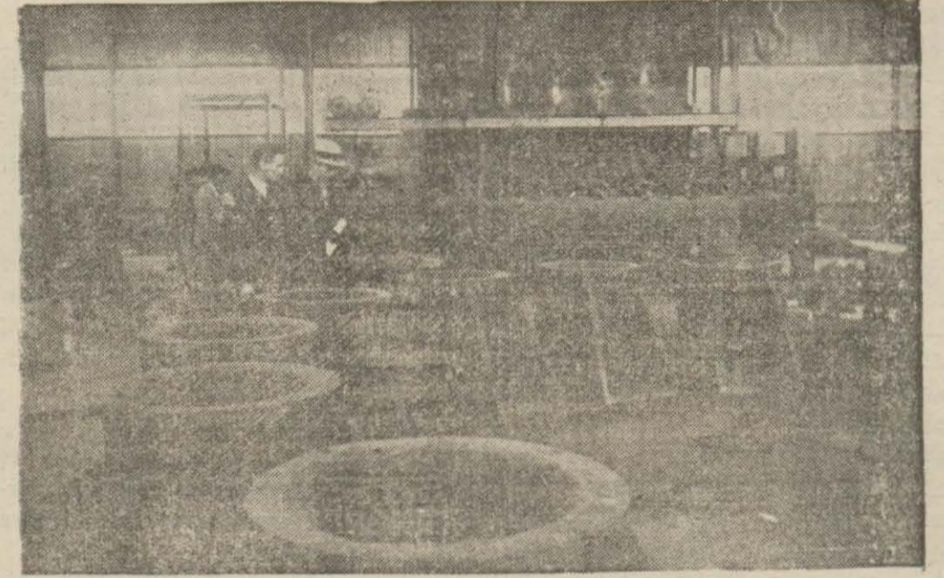
Demir boru fabrikasının kalıpları
